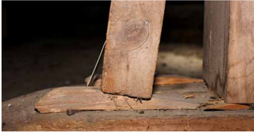
Kilen løfter beinet litt ut av tappullet i fotplaten. Foto: Thor-Aage K. Heiberg.
