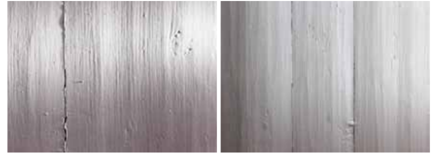
Med hjelp av sidelys kommer høvelsporene i panelbordene tydelig frem. Her fra baksiden av prekestolalteret. Foto: Thor-Aage K. Heiberg.
